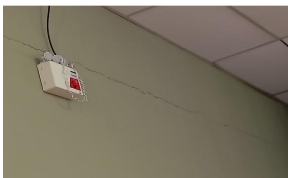
Figura 2 - Fissura na estrutura
