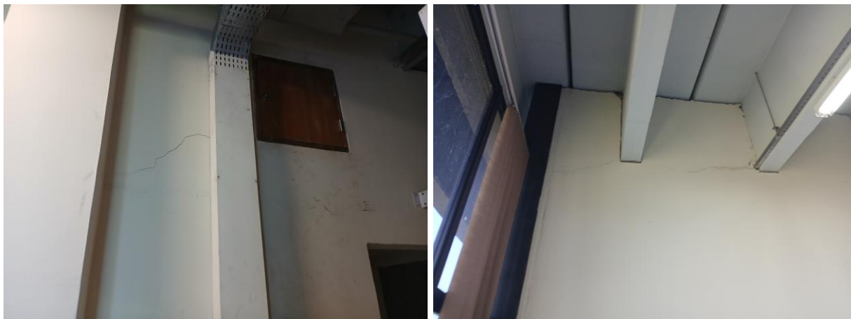
Figura 7: Rachaduras na área próxima à porta de entrada.
