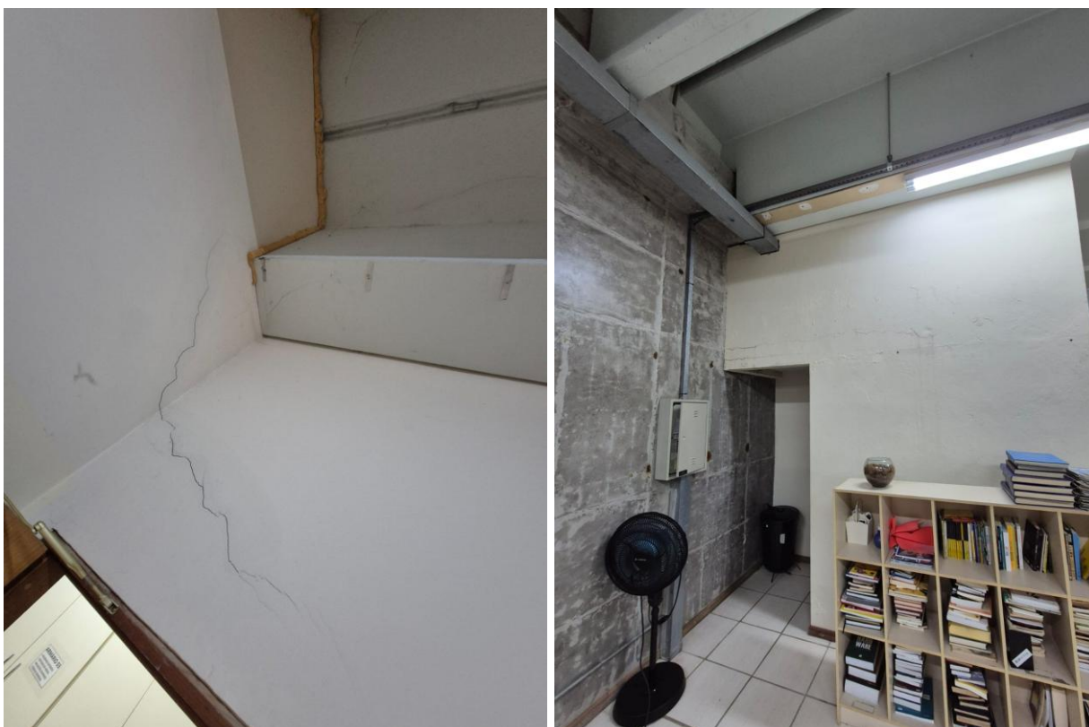
Figura 14: Rachaduras em salas de aula.
