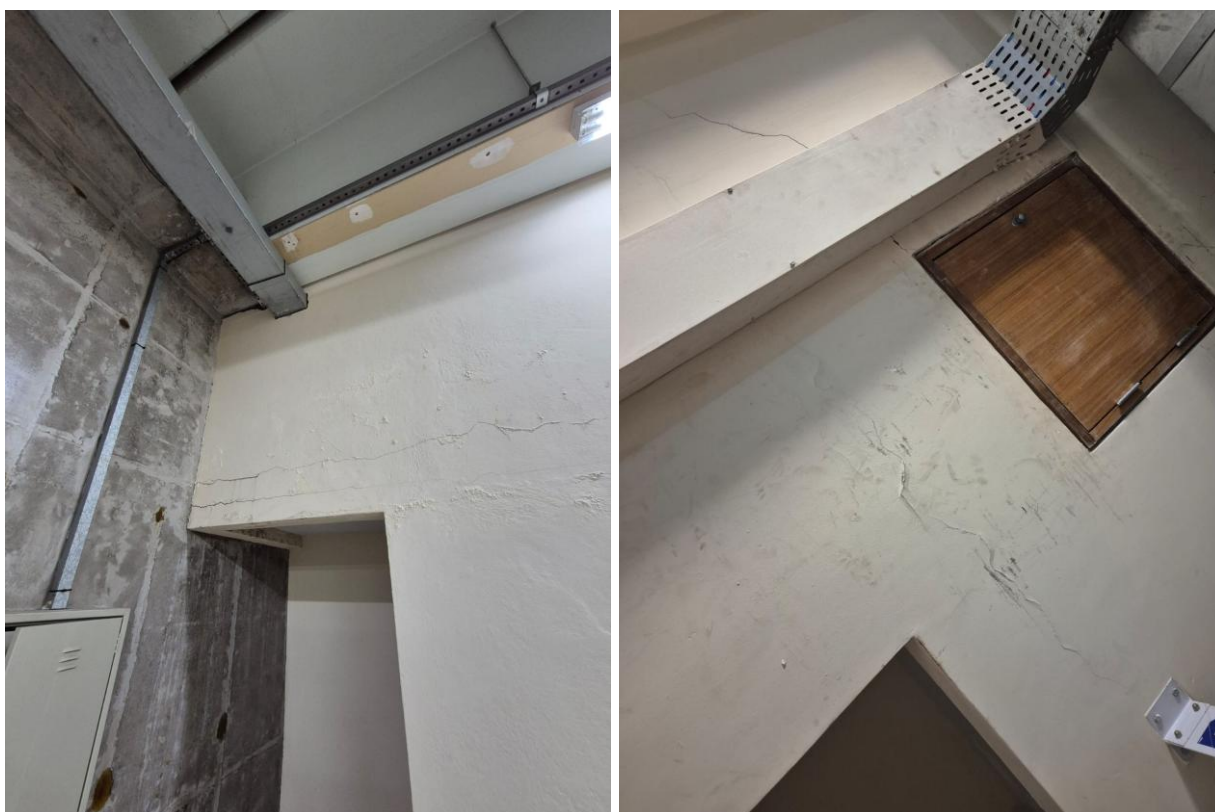
Figura 12: Rachaduras na área técnica.
