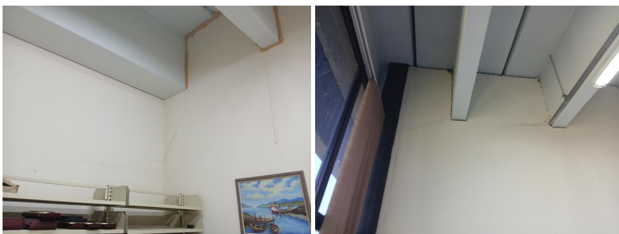
Figura 8: Rachaduras nas salas de aula.
