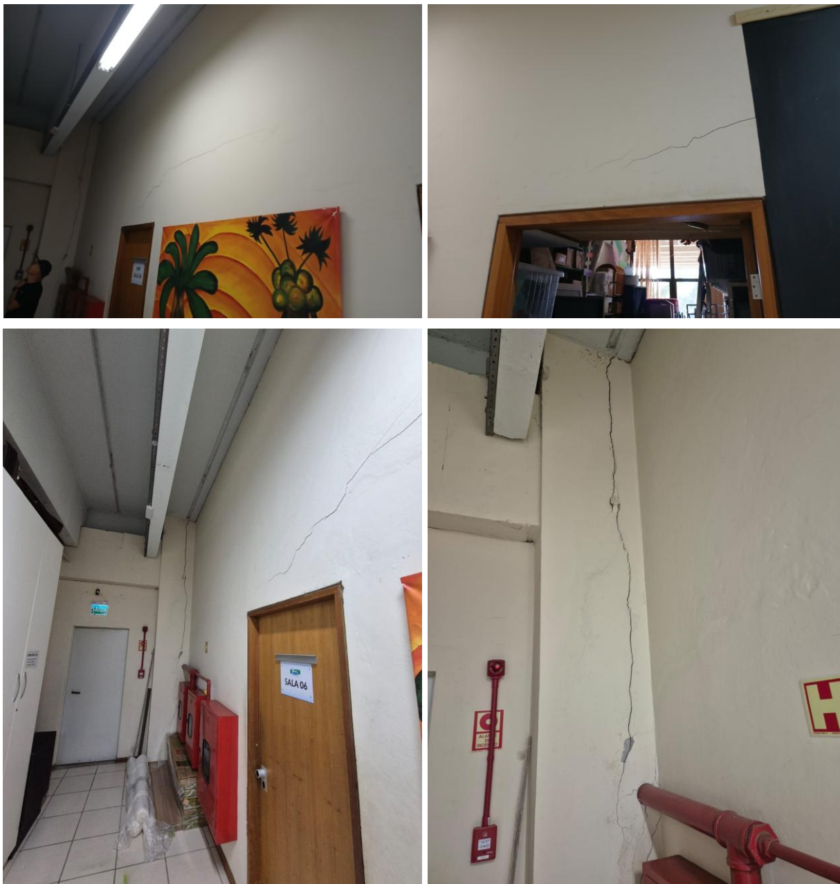
Figura 6: Rachaduras na circulação.
