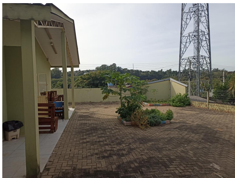
Figura 4: Local de execução da estrutura.
