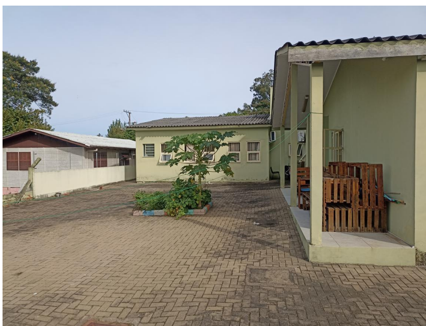
Figura 2: Vista lateral norte do local de execução da estrutura.
