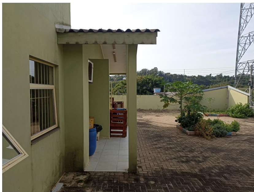
Figura 3: Vista lateral sul do local de execução da estrutura.
