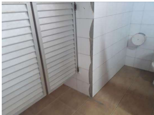
Figura 31: Cerâmicas quebradas na parede do banheiro feminino.
