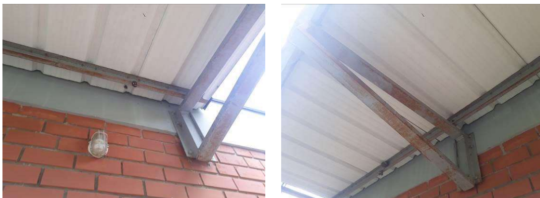
Figura 21: Estruturas metálicas dos beirais.
