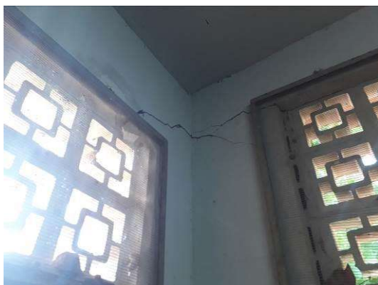
Figura 33: Rachaduras nas paredes.
