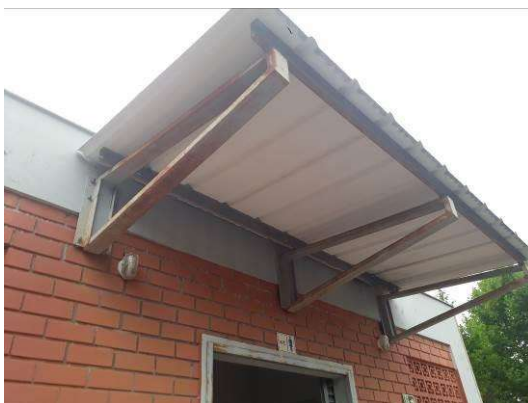
Figura 35: Estruturas metálicas dos beirais.
