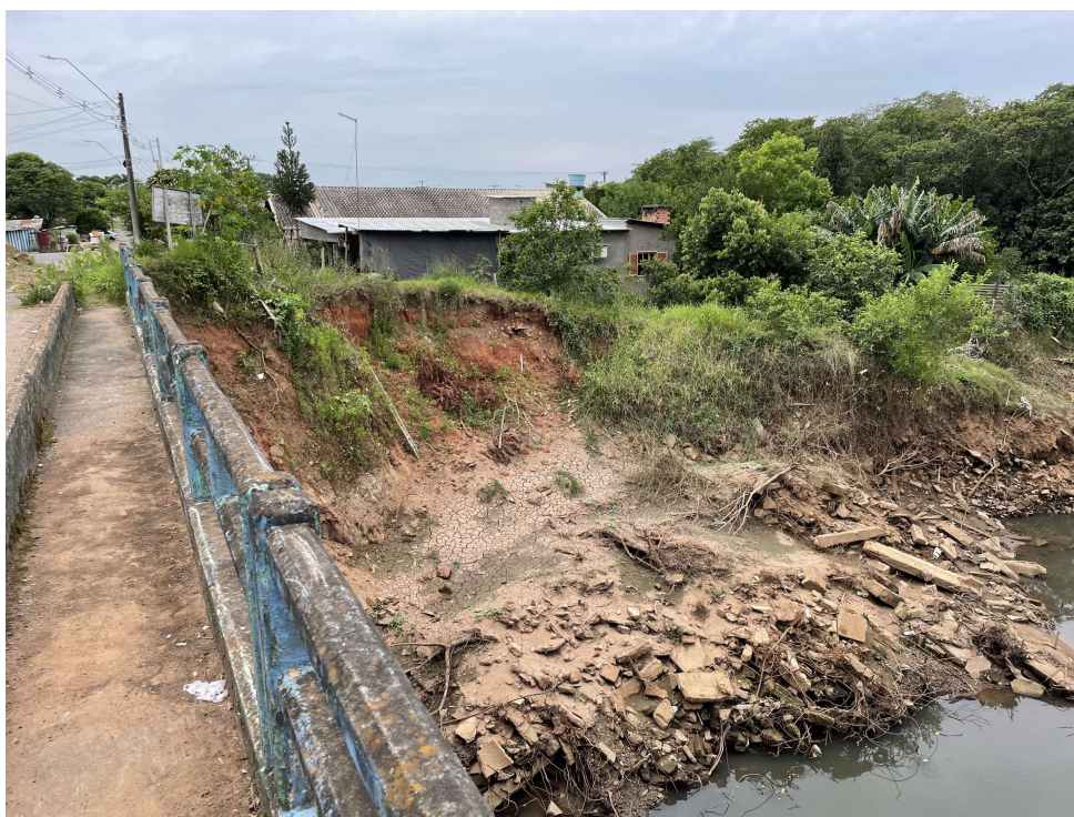
IMAGEM 4 – Vista lateral da erosão do talude de contenção
