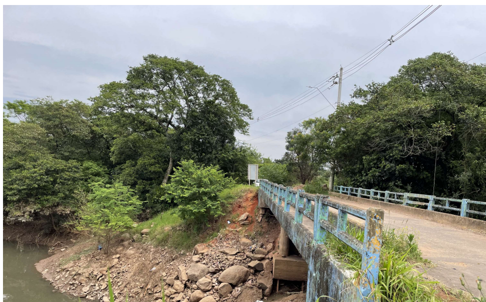
IMAGEM 5 – Vista lateral da estrutura de apoio comprometida
