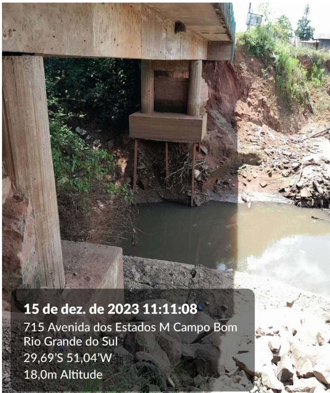
IMAGEM 6 – Vista da estrutura de apoio desprotegida da Ala direita
