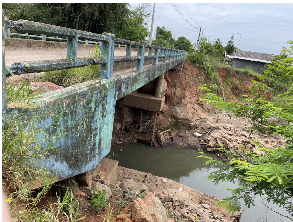
IMAGEM 3 – Vista lateral com a estrutura de apoio exposta
