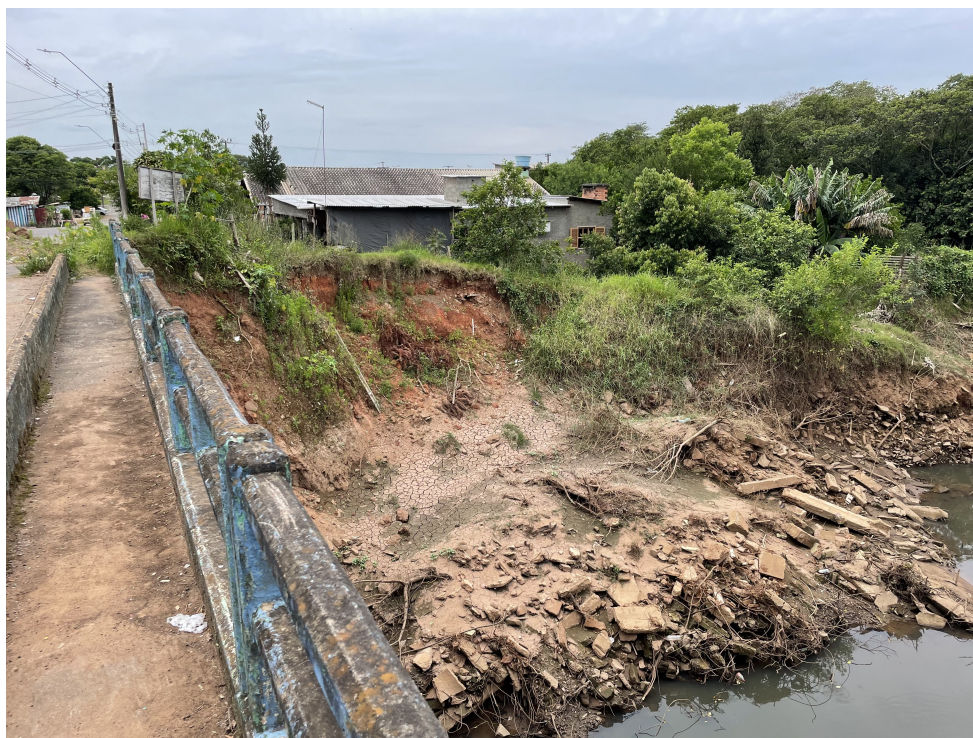
IMAGEM 4 – Vista lateral da erosão do talude de contenção
