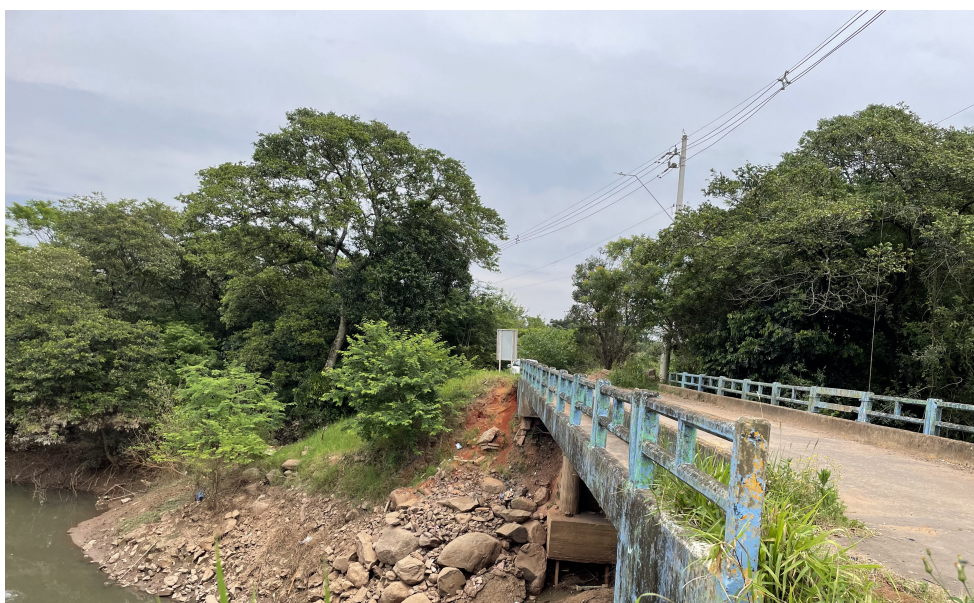
IMAGEM 5 – Vista lateral da estrutura de apoio comprometida
