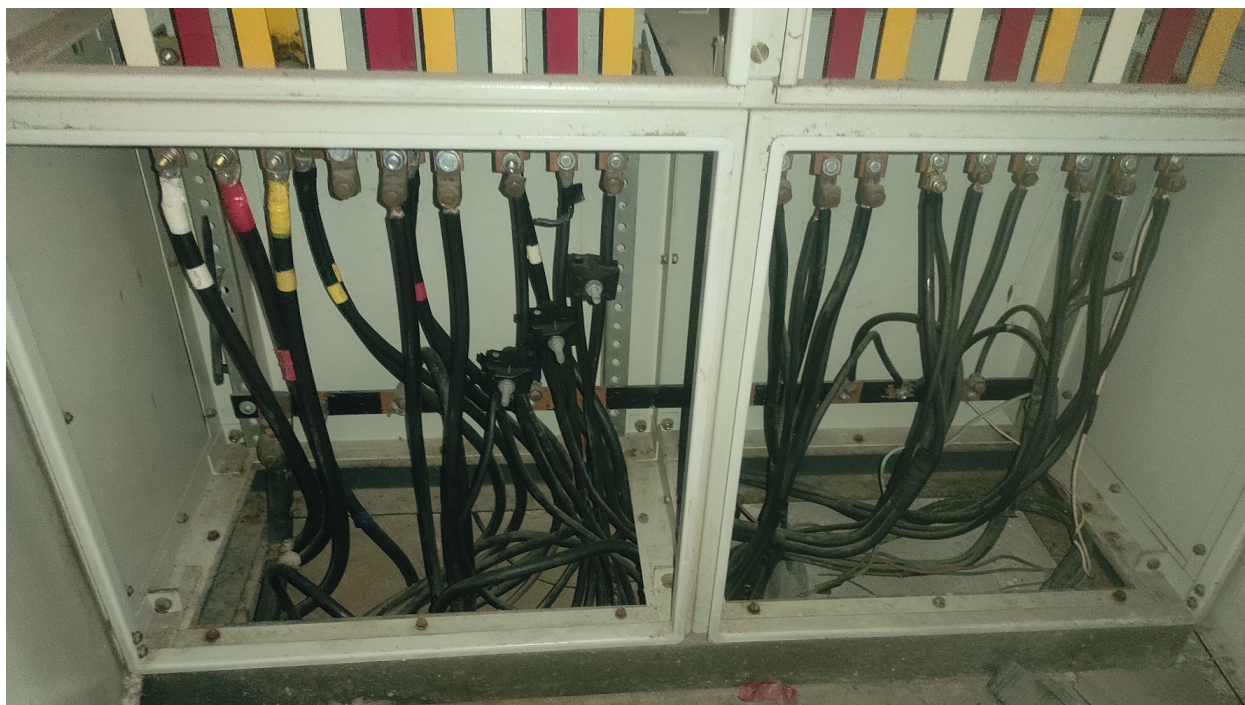
Cabeamento de entrada e saída pelo piso
